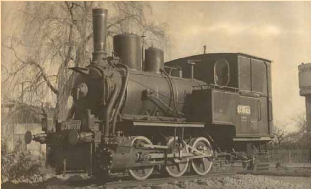
▲ Lokomotíva U 36.003 bola dlho ozdobou RD Spišská Nová Ves, ktorú zamestnanci pravidelne natierali a udržiavali. Chýbajúce časti rozvodov nahradili drevenými replikami. (zbierka OZ DŽK)
