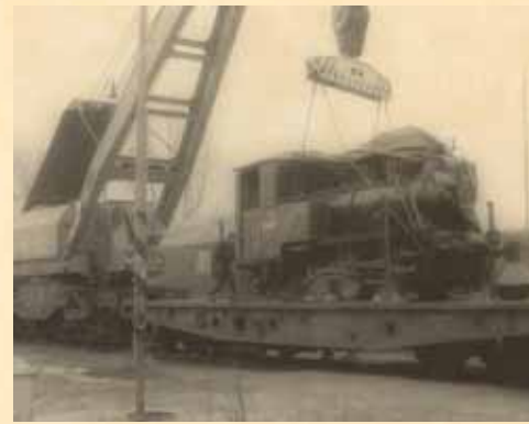
▲ V decembri roku 1990, takmer po 25 rokoch, sa sen stáva skutočnosťou. Do areálu RD Košice priviezli na plošinovom vozni zo ŽOS České Velenice nový symbol detskej železnice – parný rušeň U 36.003. Na koľajnici ho skladá žeriav pomocného vlaku. (foto František Koprovič)
