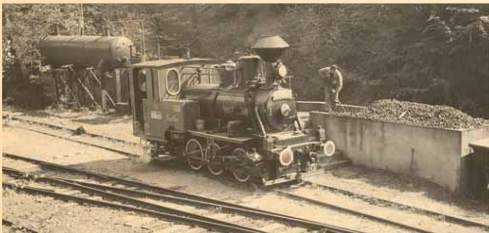
▲ Každý nový deň parného rušňa U 36.003 začínal jeho zbrojením. Sklad uhlia dodnes tvorí betónový násypník, v súčasnosti je prekrytý plechom. Pôvodne sa však uvažovalo o použití staršieho nákladného vozňa z TEŽ-ky, riešenie sa však ukázalo ako nepraktické. (foto Peter Cuninka, 1.5.2001)
